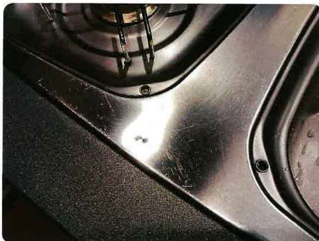
9.4 Øvrige feil Mangler støtputer 5 stk
