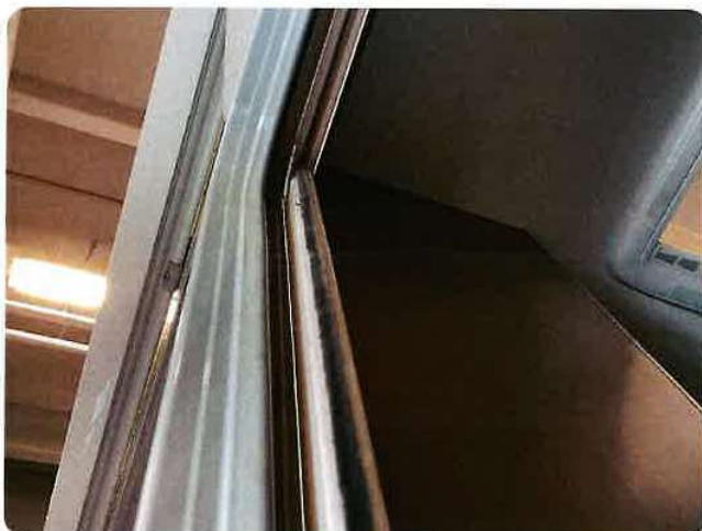
2.4 Øvrige feil Løs myggdør + ødelagt i bunn. Hopper ut av spor
