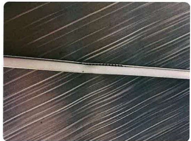
8.3 Defekt Markise går ikke som den skal. Henger igjen i bakkant. Skade på hovedarm venstre. Bakre
