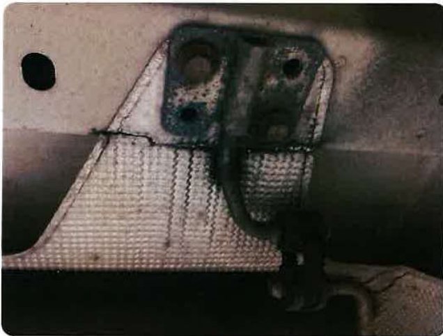
2.2 Beskyttelsesplate skadet/mangler Defekt eksoskjold
