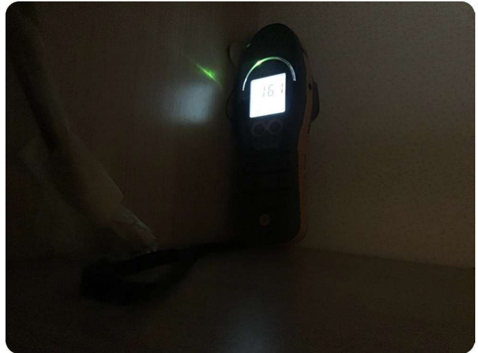
2 Målt fukt i % 16 Misfarge på skap og i tak. Har vært fukt her men måler ikke fukt i dag. Ingen dokumentasjon på tester tidligere
